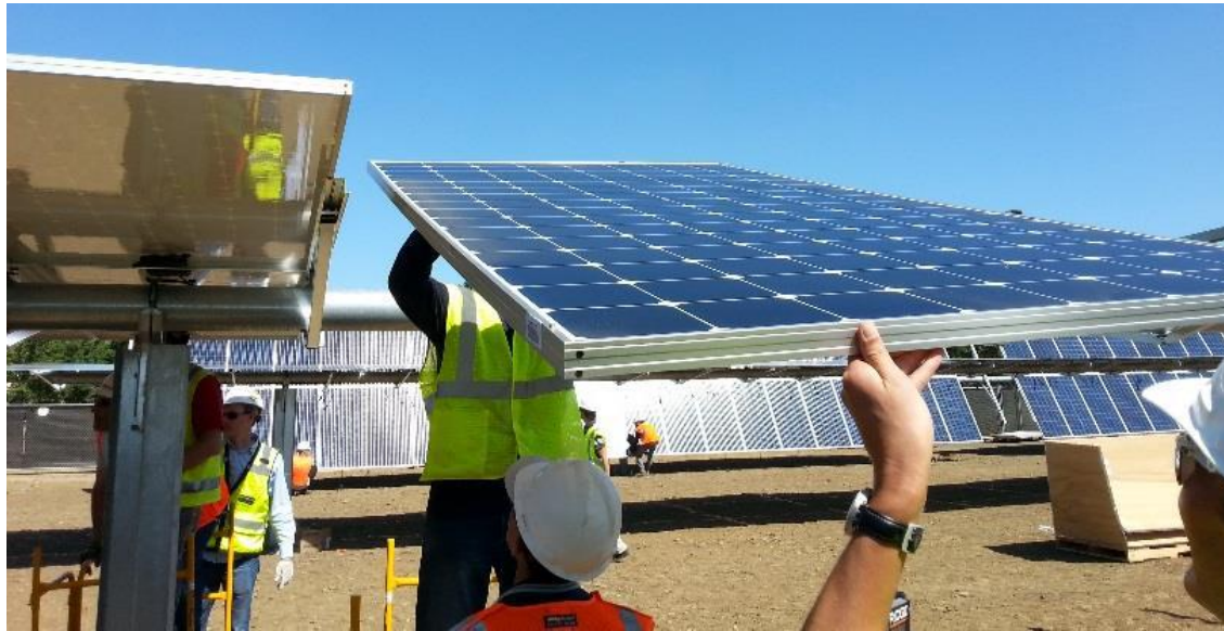
Figure 67 : Mise en place des panneaux photovoltaïques
