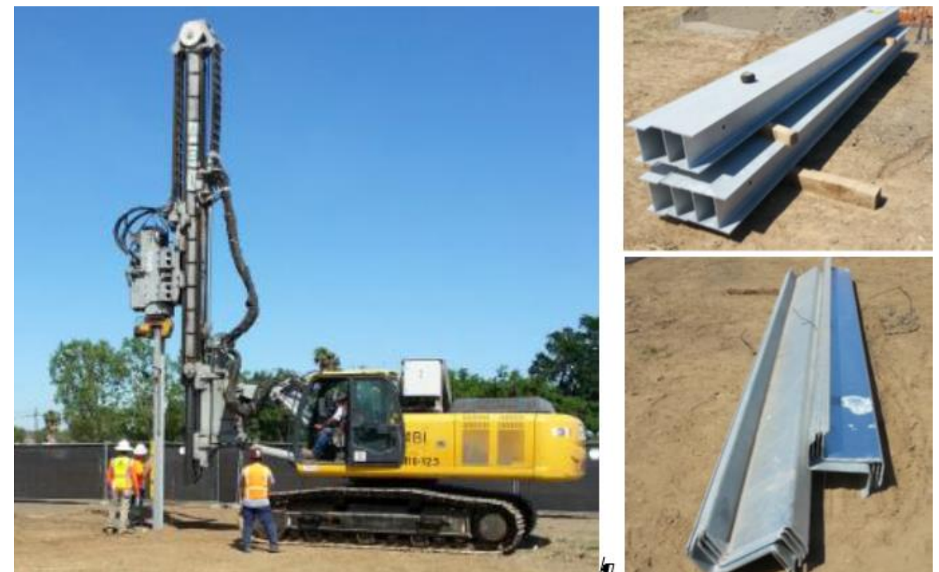
Figure 66 : Mise en place des pieux battus au sol
